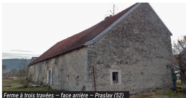
Ferme à trois travées – face arrière – Praslay (52)
