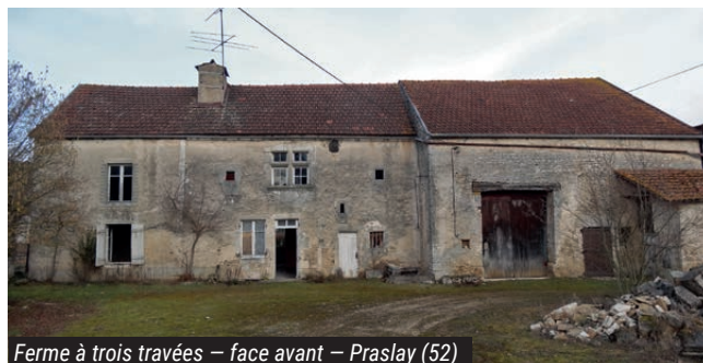
Ferme à trois travées – face avant – Praslay (52)
