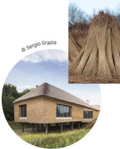
FAÇADE ET TOITURE TYPE CHAUME
