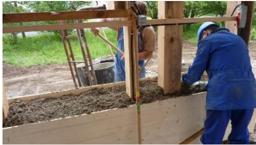
Béton banché Stampfbeton
