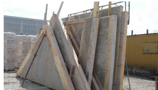
Préfabrication de murs Vorgefertigte Wände
