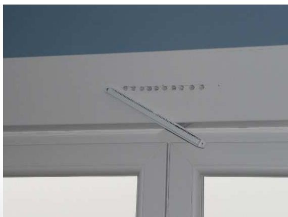
Réserve mortaise insuffisante – perçage sur chantier. Source CEREMA
