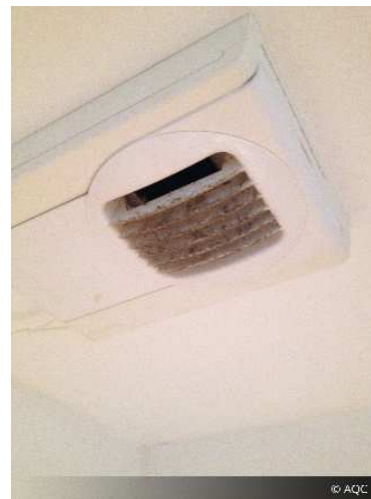
Bouche encrassée - AQC
