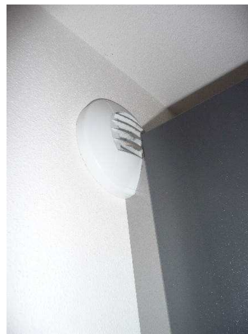
Obstruction de la bouche d'extraction. Source CEREMA
