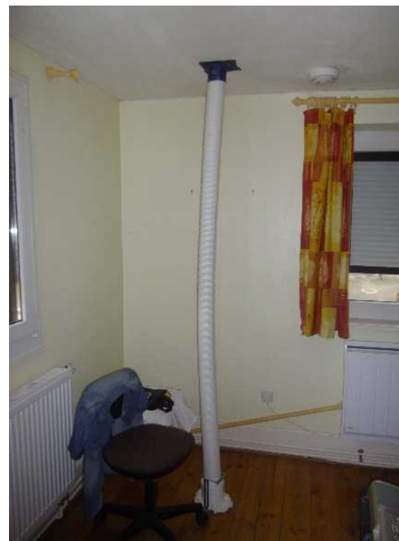
Conduit de ventilation dans le salon. Source EDF
