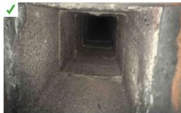
L'objet obturant partiellement le conduit, identifié et localisé lors de l'inspection vidéo, a été retiré. @Air efficience
