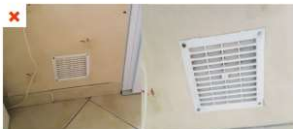
L'ancienne entrée d'air située dans la cuisine n'a pas été obturée lors de la rénovation, ce qui perturbe la bonne circulation de l'air dans le logement. @AQC
