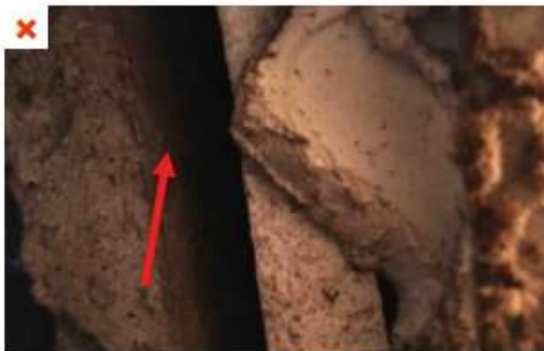
L'espacement entre la paroi support de la bouche d'extraction et le conduit vertical de type Shunt ne permet pas d'assurer une continuité de l'étanchéité à l'air du réseau. @Air efficience
