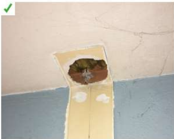
Le passage d'une ancienne gaine de ventilation a été identifié, isolé et va être rendu étanche à l'air. @AQC
