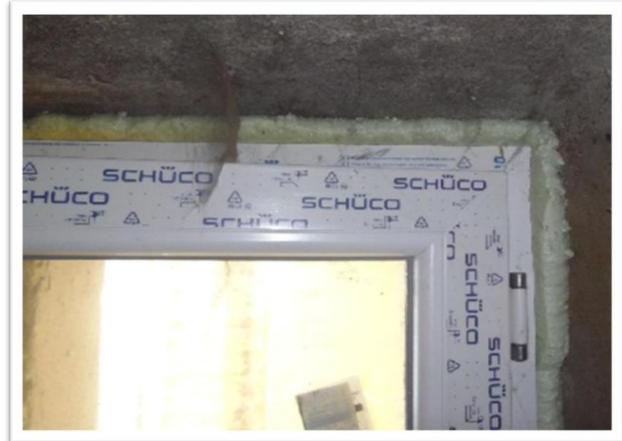
*Utilisation récurrente de la mousse polyuréthane pour le traitement des jonctions, en lieu et place de produits adaptés*
