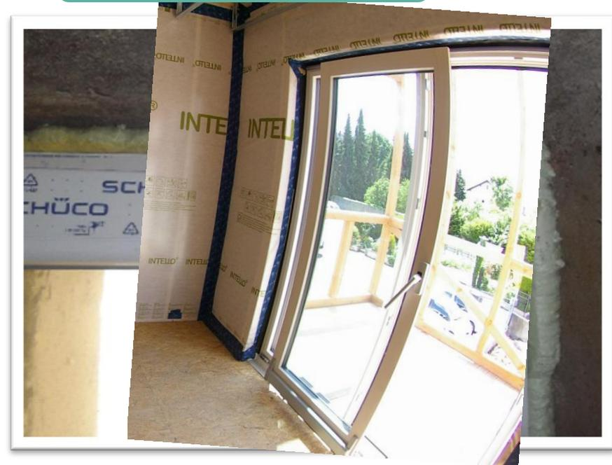
*Utilisation récurrente de la mousse polyuréthane pour le traitement des jonctions, en lieu et place de produits adaptés*
