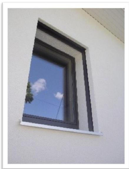
*Caisson de volet roulant est « pris » dans l'isolant.*
