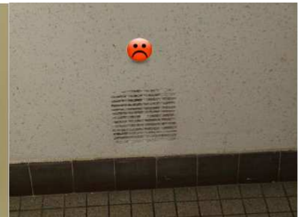
Illustration 12: Exemple de grille d'entrée d'air, en partie obturée par le revêtement intérieur
