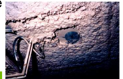
Flocage d'amiante © B.Floret / INRS
