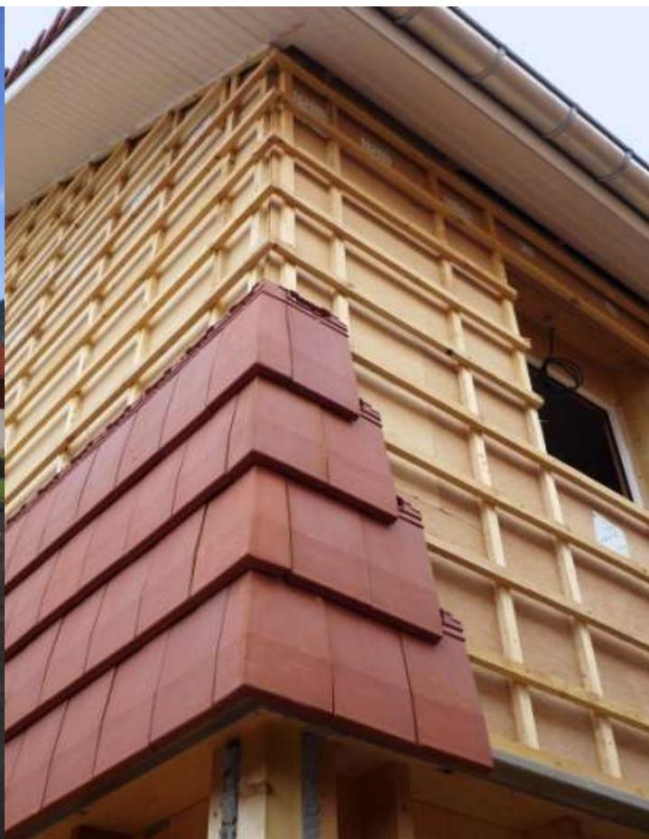
Pavillons HLM à St-Dié des Vosges en panneaux bois massif contrecollé avec isolation des caissons, ITE + crépi ou finition bardage bois et tuile
