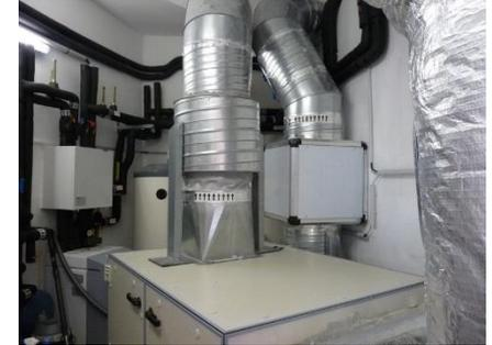
débit d'air : 450 m<sup>3</sup>/h à 1350 m<sup>3</sup>/h - humidification nécessaire : 3 kg à 6.8 kg H<sub>2</sub>O/h
