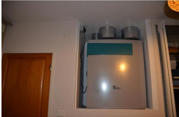
Centrale de ventilation domestique double flux (200-300 m<sup>3</sup>/h)
