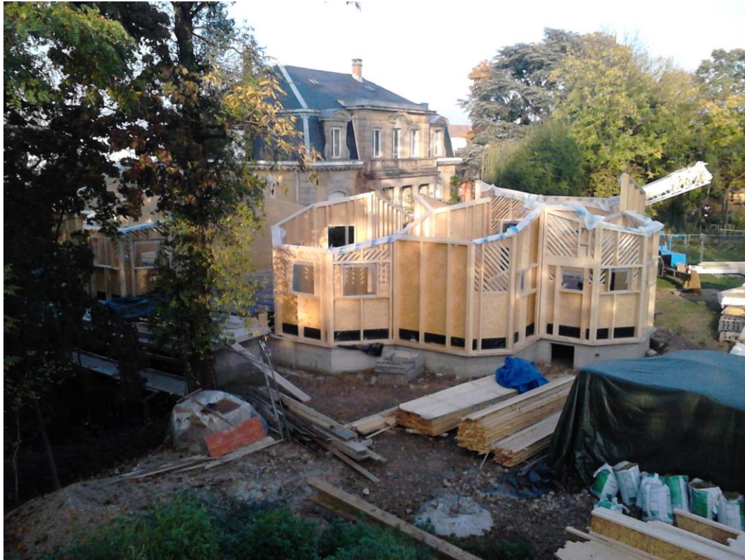
Charpente et ossature bois
