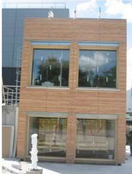
Vue de la façade à t = 0
