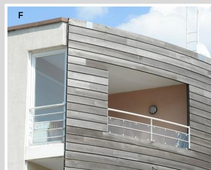
La façade ouest quant à elle, réalisée à l'aide d'un enduit, est marquée par le passage de la pluie (F). De la même manière, les garde-corps métalliques, recouverts d'une peinture blanche, ont, 24 ans plus tard, des traces de rouilles.
