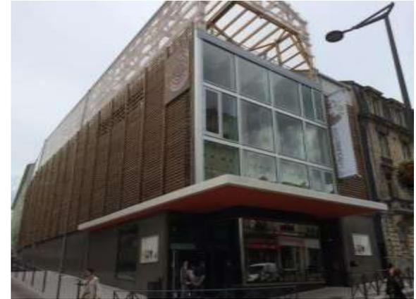
Le Hêtre recouvre 500 m<sup>2</sup> de la façade. Il est thermo-huilé pour un usage en bardage extérieur. Il est utilisé à l'intérieur en parquet et en lames verticales pour la correction acoustique.
