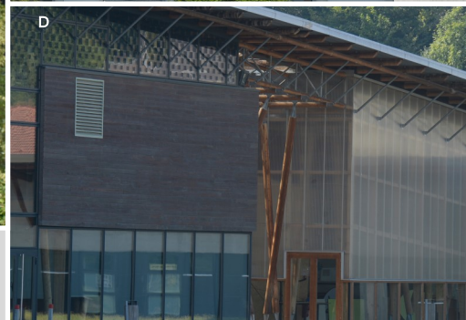
B : Partie sud-ouest du bâtiment, 2018 — C : Mur crépi du garage en 1 er plan, bardage lame horizontale en 2 nd plan, bardage lame verticale en 3 ème plan, 2018 — D : Bardage lame horizontale sous protection du débord de toiture, 2018
