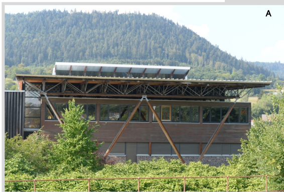
A : Façade sud-est, on peut voir la charpente et son débord de toiture, protégeant la façade, et reposant sur les poteaux en « V », 2018
