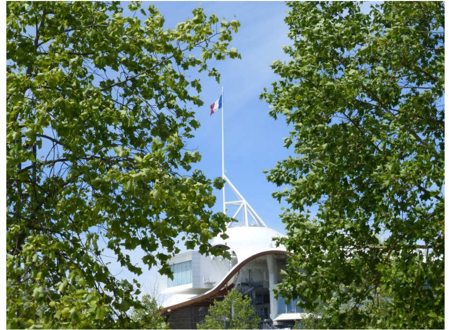
Le Centre Pompidou Metz (Metz), photo Luc Chrétien (Cerema)
