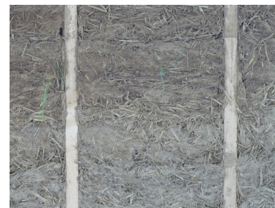
Chantier - Isolation intérieure en terre/paille banchée Chez des particuliers - Reims
