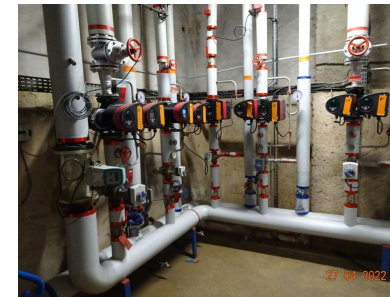
Ensemble de pompes à vitesse variable Lycée Fabert à Metz
