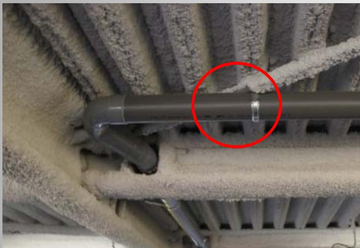
*Collision entraînant la destruction du flocage du contreventement du plancher haut*
