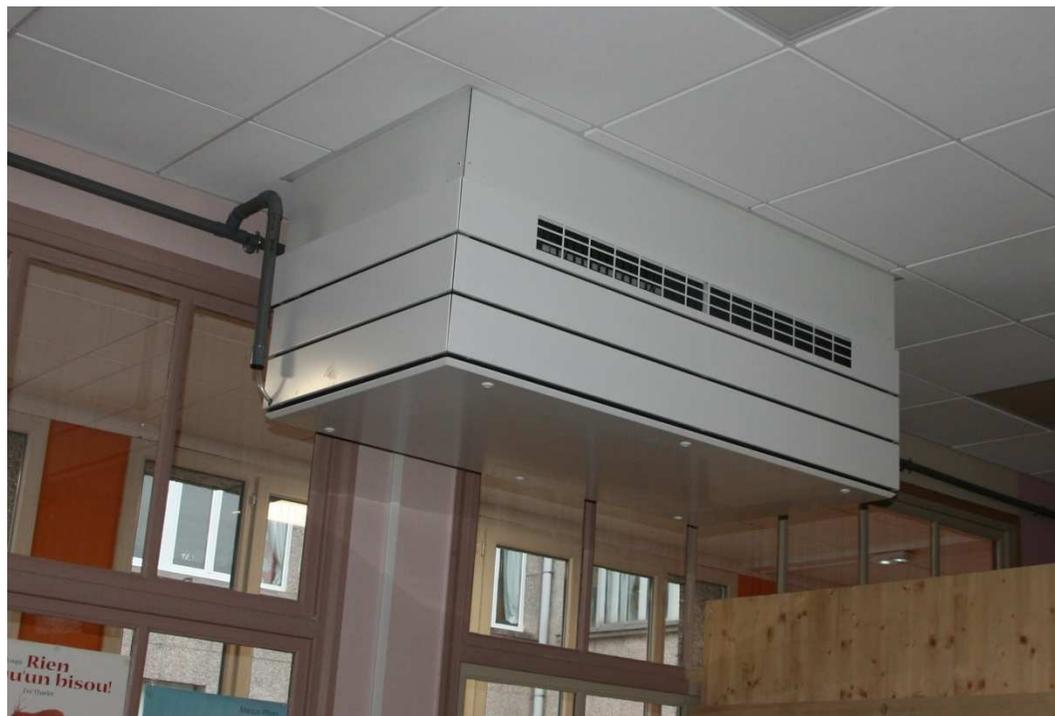
Évacuation des condensats nécessitant une pompe de relevage
