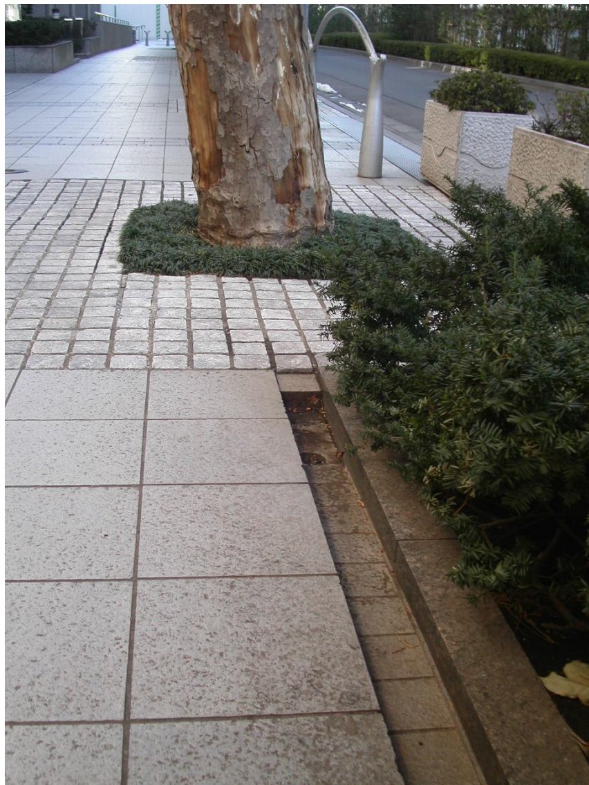
TOKYO – DISPOSITIF DE RÉCUPÉRATION DES EAUX PLUVIALES
