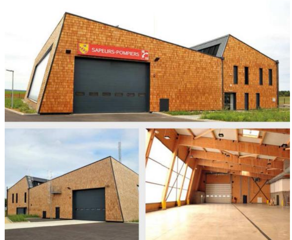
Centre d'incendie à Colombey-lès-belles (54)
