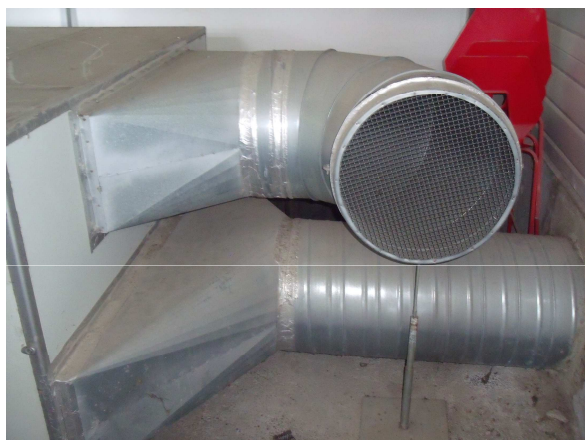
Sortie et entrée de la VMC double flux
