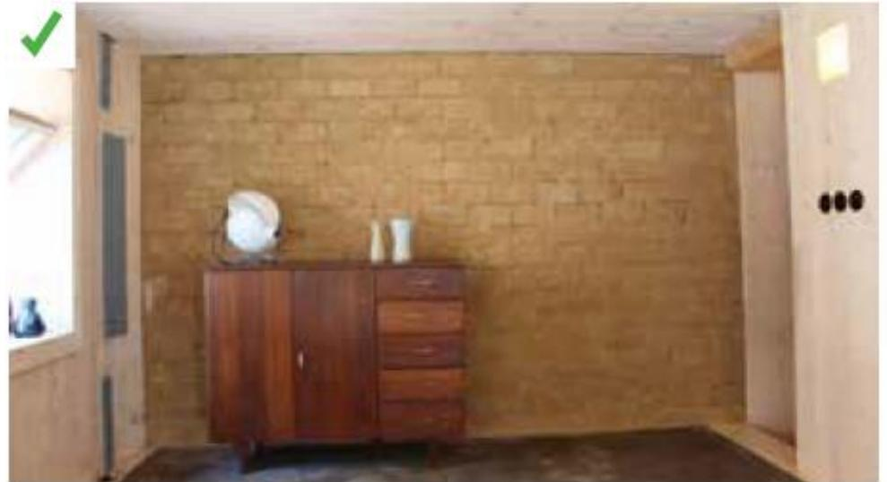
*L'augmentation de la température de l'air intérieur est limitée par la capacité de stockage des matériaux denses dont la température est plus faible. On parle d'inertie d'absorption. ©AQC*
