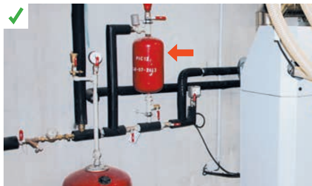
Pot de traitement du circuit primaire. ©AQC
