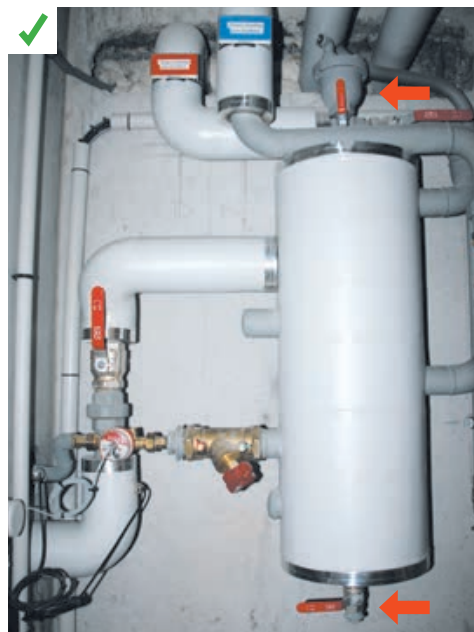
Bouteille casse pression avec purge en partie basse et dégazeur en partie haute. ©AQC
