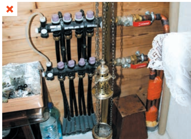
Réseau primaire en cuivre et réseau secondaire du plancher chauffant en PER (situation à risque si le PER est sans barrière anti oxygène). ©AQC
