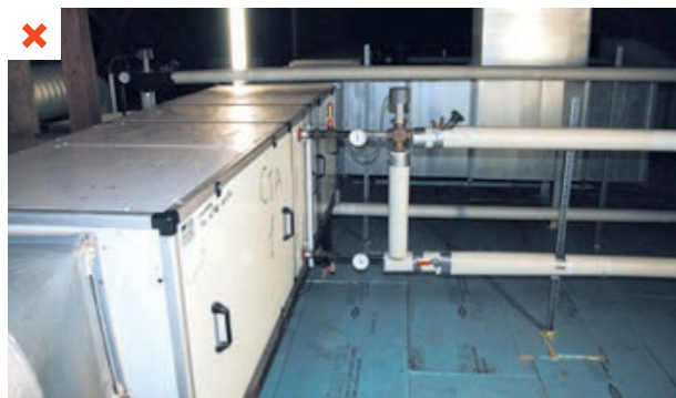
Régulation terminale par vanne trois voies au niveau de la CTA. Tout le circuit en amont est à haute température. ©AQCC
