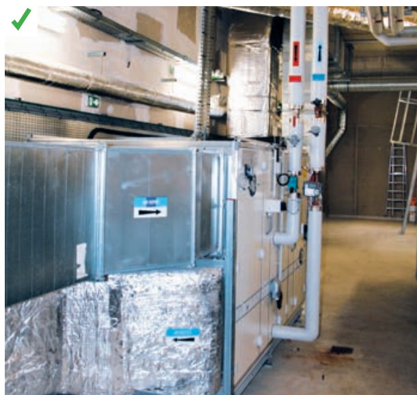
Régulation terminale par vannes deux voies associées à une pompe à débit variable permettant de réduire le débit dans la CTA. Ceci permet également de diminuer la consommation électrique des auxiliaires qui sont moins sollicités. ©AQCC
