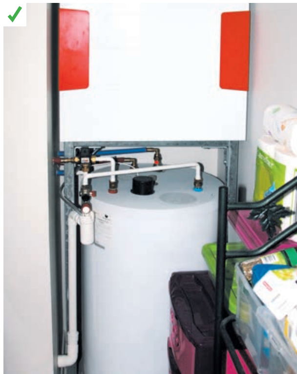
Dans un bâtiment d'habitation collective passif, ce ballon individuel de 150 L est situé très proche du point de puisage. ©AQC
