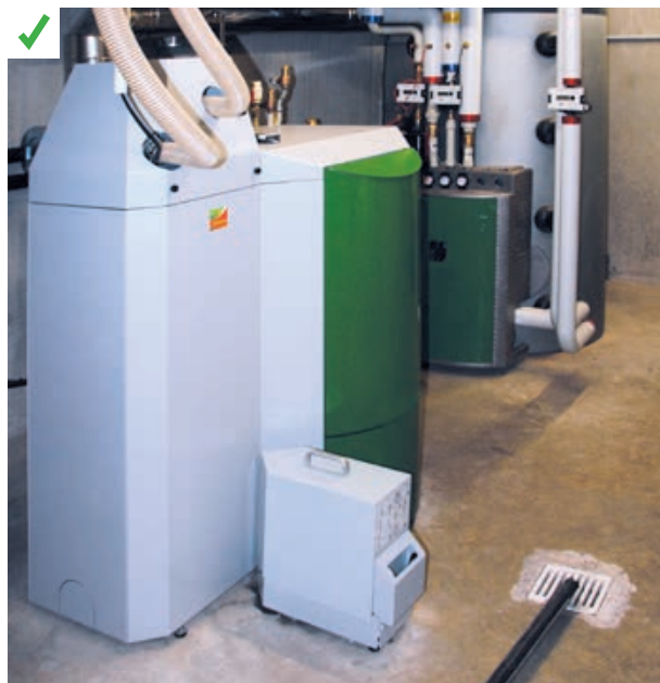
Chaudière à granulés de bois et son ballon d'hydro-accumulation. ©AQC
