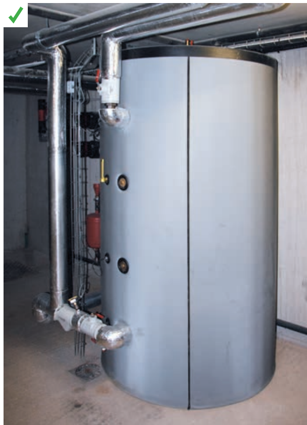
Ballon tampon 3 000 L servant de réservoir de chaleur pour le chauffage et l'eau chaude sanitaire de 18 logements passifs. La chaudière à pellets qui l'alimente à une puissance de 32 kW. ©AQC
