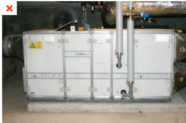
Les CTA sont plus réactives que les systèmes de chauffage à forte inertie. Elles montent vite en température et prennent le pas sur le système de chauffage principal. ©AQC
