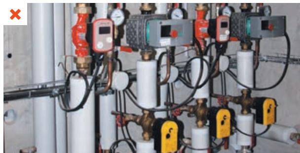
Panoplie d'un bâtiment passif : vannes et circulateurs non isolés. ©AQC
