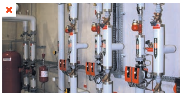
Vannes et circulateurs non isolés. ©AQC
