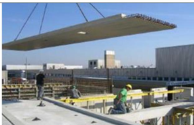
Pose d'un plancher préfabriqué en usine
