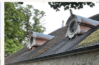
Lucarne sur le versant du toit
