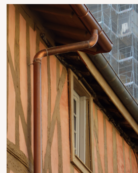
Gouttière en cuivre
