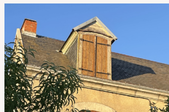
Lucarne en aplomb de la façade
