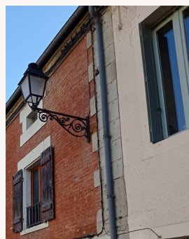
Gouttière en zinc
