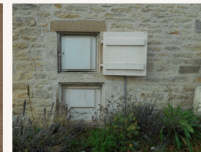
Camouflages d'éléments techniques derrière des volets aux lettres
