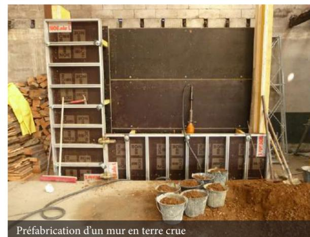
Préfabrication d'un mur en terre crue
