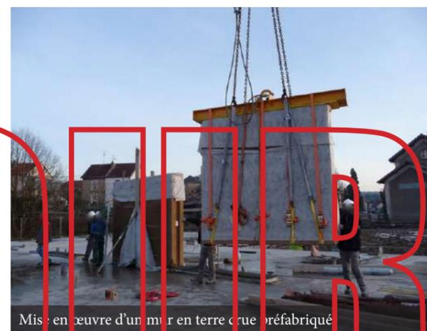
Mis en œuvre d'un mur en terre crue préfabriqué
