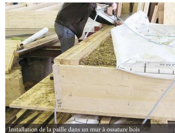
Installation de la paille dans un mur à ossature bois
