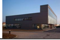
Bâtiment 1 : Bureaux de l'Observatoire à LAXOU
