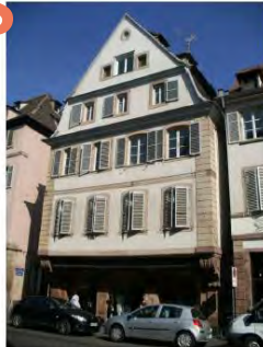
Façade du XVIII e siècle : valeur de typologie architecturale, génie constructif, de ancienneté, d'authenticité et d'intégrité © Bailly-Leblanc
