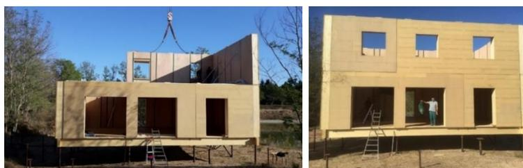
Un des intérêts majeurs de ce type de système constructif c'est la quasi-absence de déchets durant les phases de chantier, car tout est préfabriqué en atelier. Les seuls déchets sont générés par les papiers de protection des films et adhésifs de traitement de l'étanchéité à l'air.
