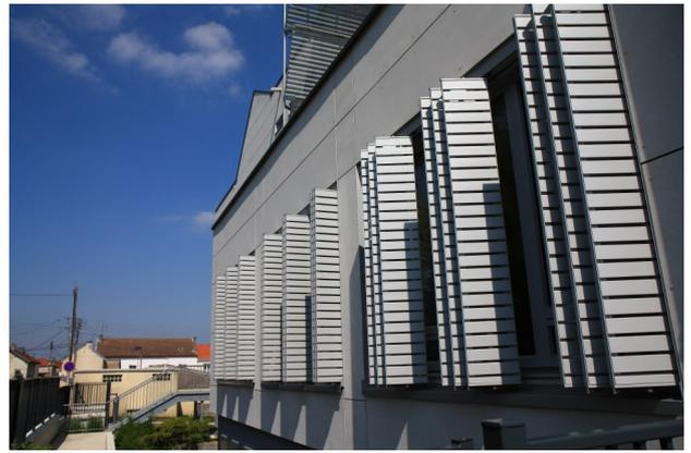
Volets à pantographes
