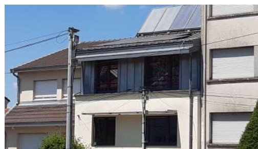
Brise-soleil débord toiture Sud
