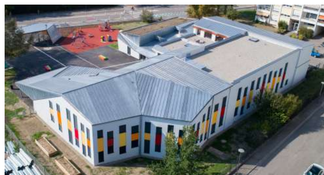
Façades Sud et Est
