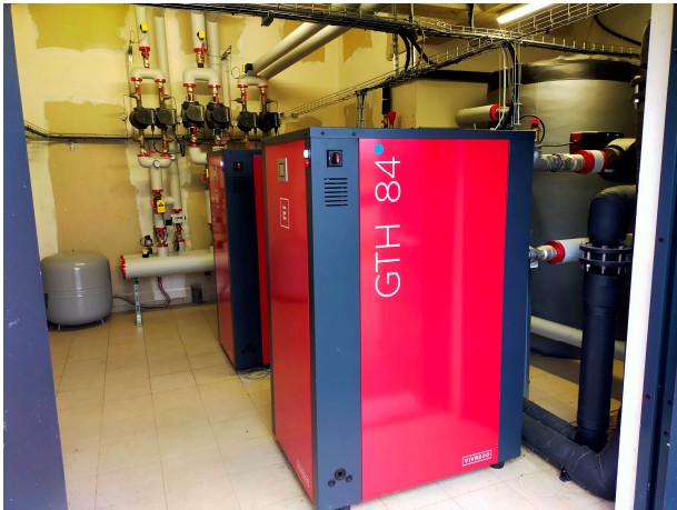
Local technique comprenant les 2 PAC géothermiques.
