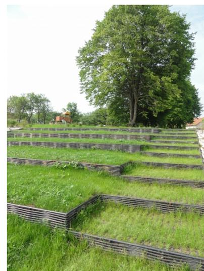
Gradins enherbés en treillis soudés
