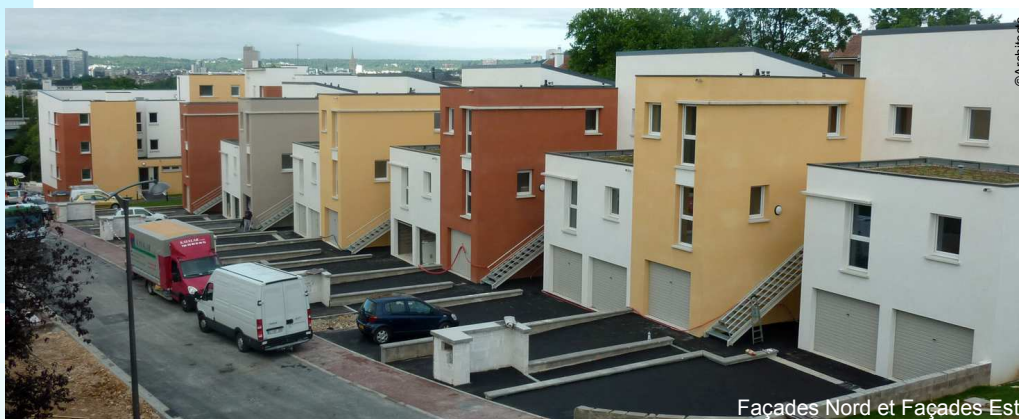
Façades Nord et Façades Est
