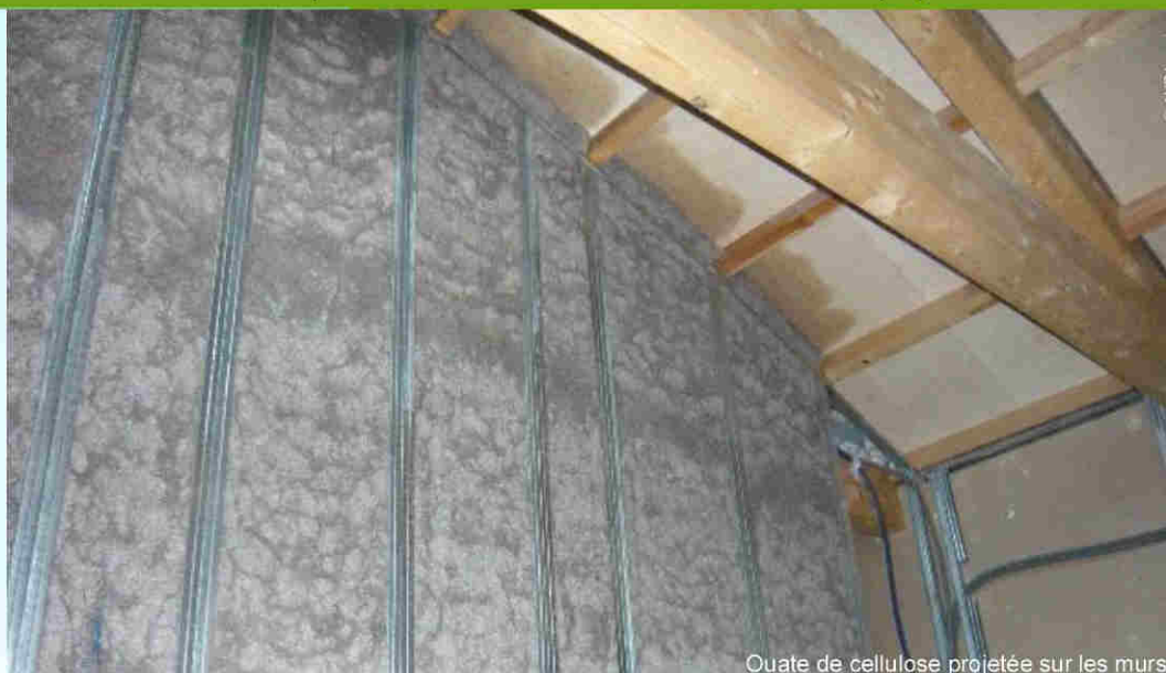
Quate de cellulose projetée sur les murs
