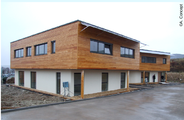
Vue d'ensemble : chantier en cours de finition
