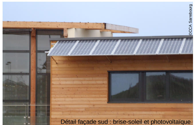
Détail façade sud : brise-soleil et photovoltaïque
