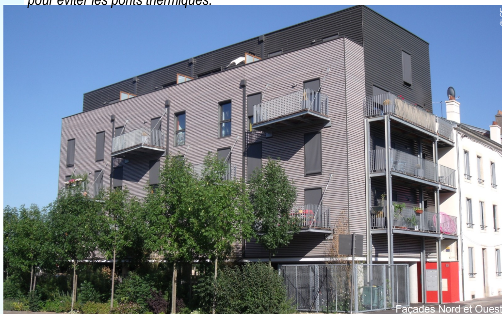
Façades Nord et Ouest
