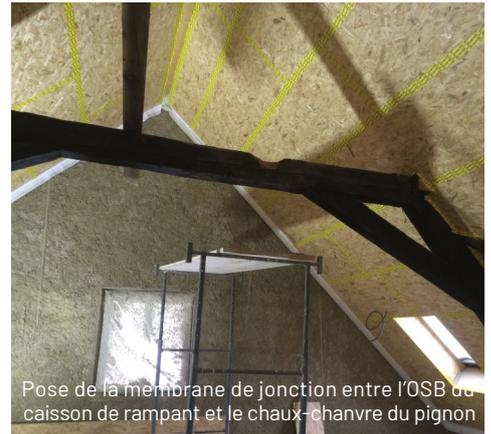
Pose de la membrane de jonction entre l'OSB du caisson de rampant et le chaux-chanvre du pignon
