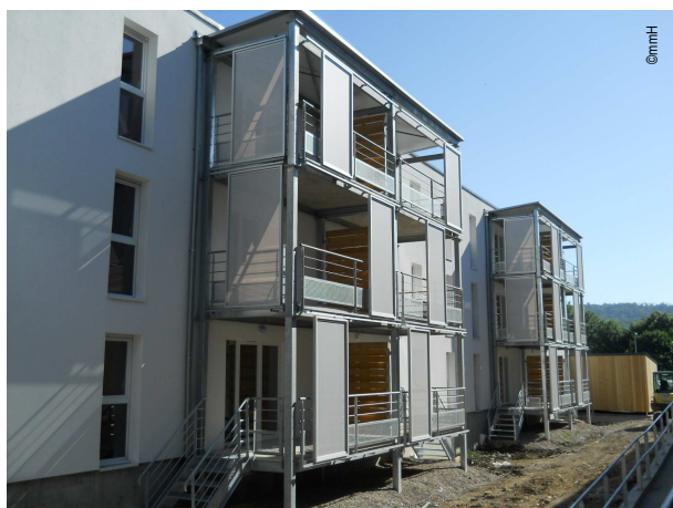
Loggia façade sud
