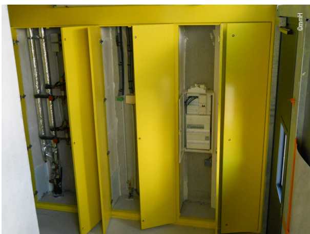
Gaines techniques dans circulation
