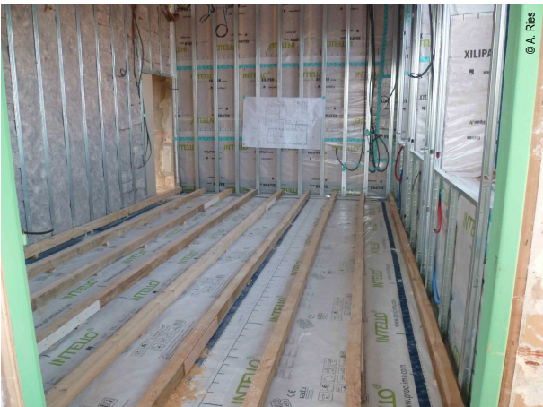
Salle du conseil : mise en œuvre de l'étanchéité à l'air
