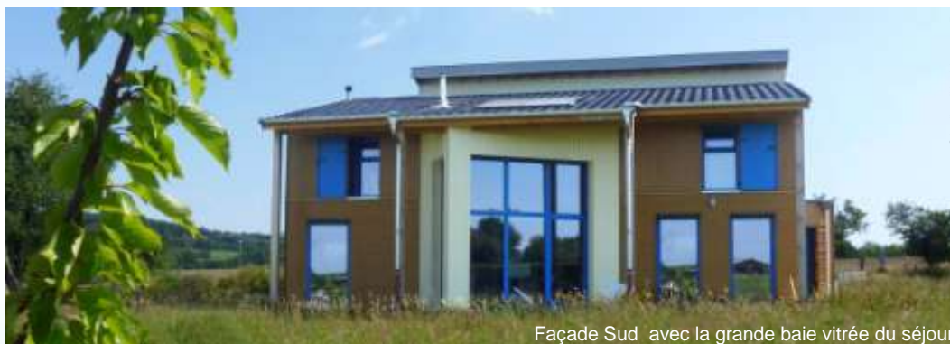
Façade Sud avec la grande baie vitrée du séjour
