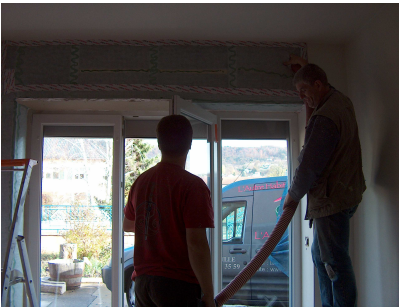
Soufflage de la ouate de cellulose
