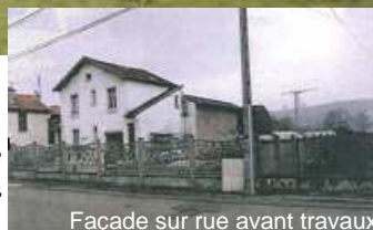
Façade sur rue avant travaux
