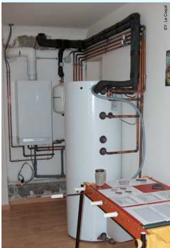
Installation chauffage et ECS
