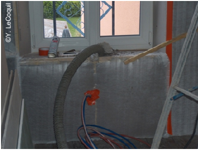
Soufflage de la ouate de cellulose
