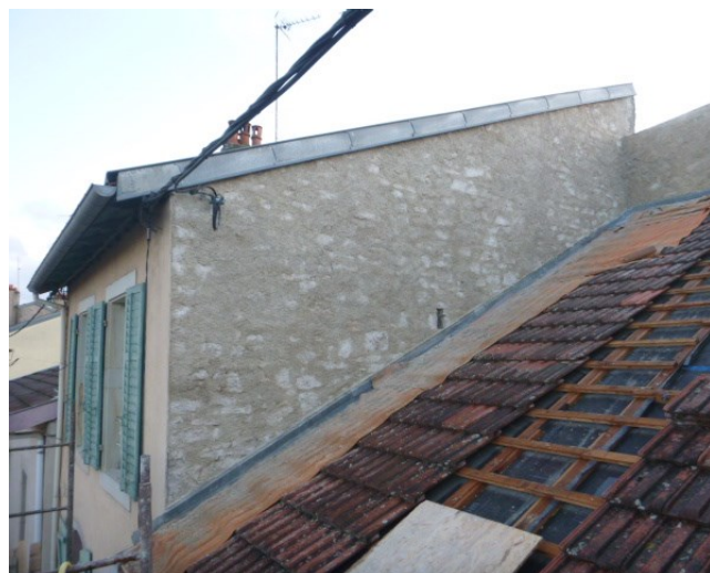
Réfection d'une des deux toitures
