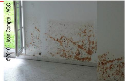
Par exemple, **une isolation par l'extérieur en polystyrène n'est pas adaptée au mur en pierre ou en moellons** car ce matériau n'est pas capillaire et ne permet pas une diffusion adaptée de la vapeur d'eau. L'humidité qui se retrouve dans le mur en pierre ne peut pas s'évacuer par l'extérieur.
