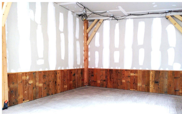
Les lames ont été prévues en pose sur ossature secondaire, orientées à la verticale et forment le revêtement du soubassement du local réemploi d'objets.
