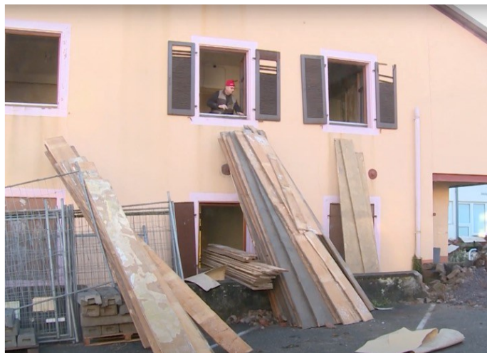
La dépose des matériaux a été réalisée directement par l'entreprise de démolition du pavillon de Lapoutroie.
