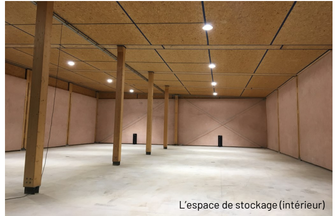
Mur en paille autoportée
