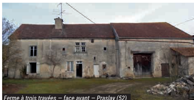
Ferme à trois travées – face avant – Praslay (52)
