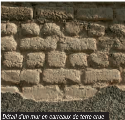
Détail d'un mur en carreaux de terre crue
