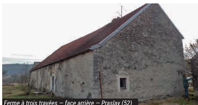
Ferme à trois travées – face arrière – Praslay (52)
