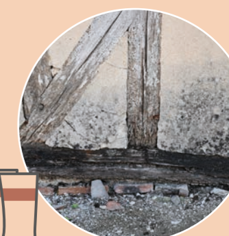
▲ Torchis et structure bois abimés par les remontées capillaires, en raison de l'absence de soubassement.
