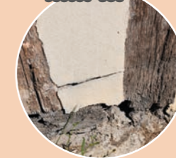
▲ Torchis et structure bois abimés par les remontées capillaires, en raison de l'absence de soubassement.
