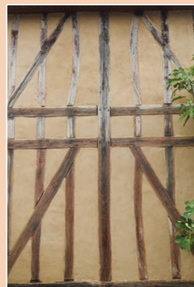
Exemple d'enduit chaux-terre pour protéger le torchis.
