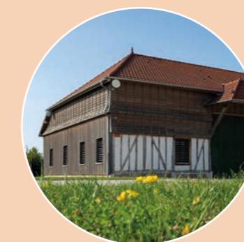
▶ Exemple de bardage sur les façades exposées de la grange communale de Géraudot - ©UPC - Charlotte Thirant.
