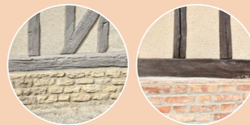
▲ Exemples de soubassements en pierre et en brique.
